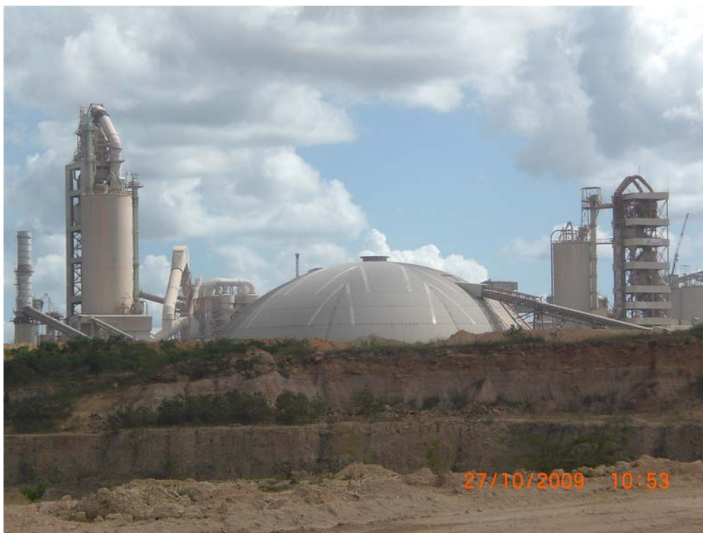
Foto 3.- Vista panorámica de las instalaciones
